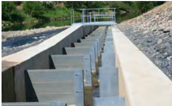
Fischpass aus TRIMAX
