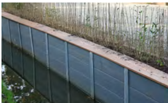
TRIMAX als Uferbefestigung
